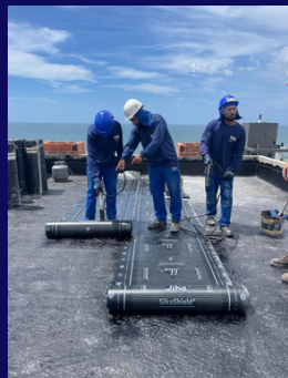
Aplicação de manta
